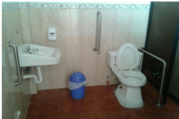
Baños para discapacitados (Anexo 14)
