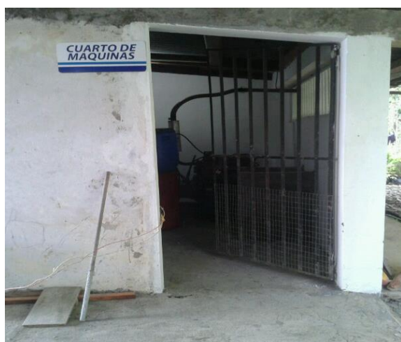
Cuarto de Máquinas (Anexo 2)
