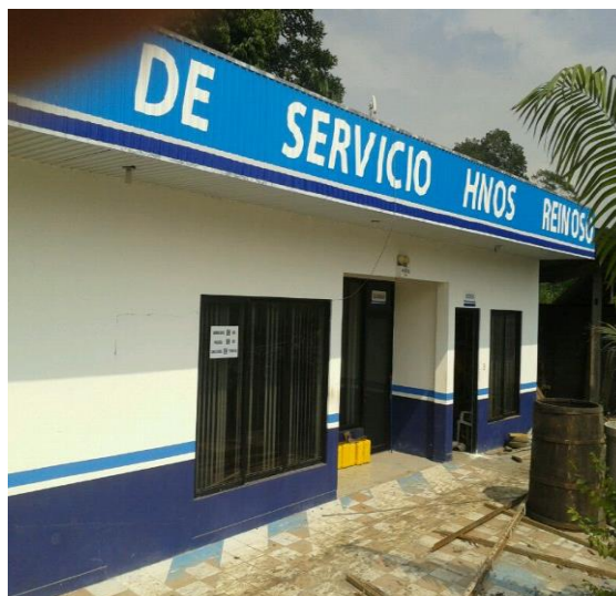
Oficinas (área administrativa)
